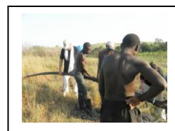
Extendiendo los tubos.
